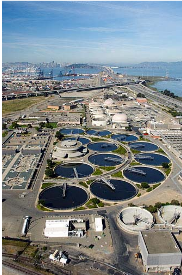
Hình 3.15. NMXLNT EBMUD, Oakland, California, Hoa Kỳ - Nhịp điệu sinh động của các bể hình tròn
