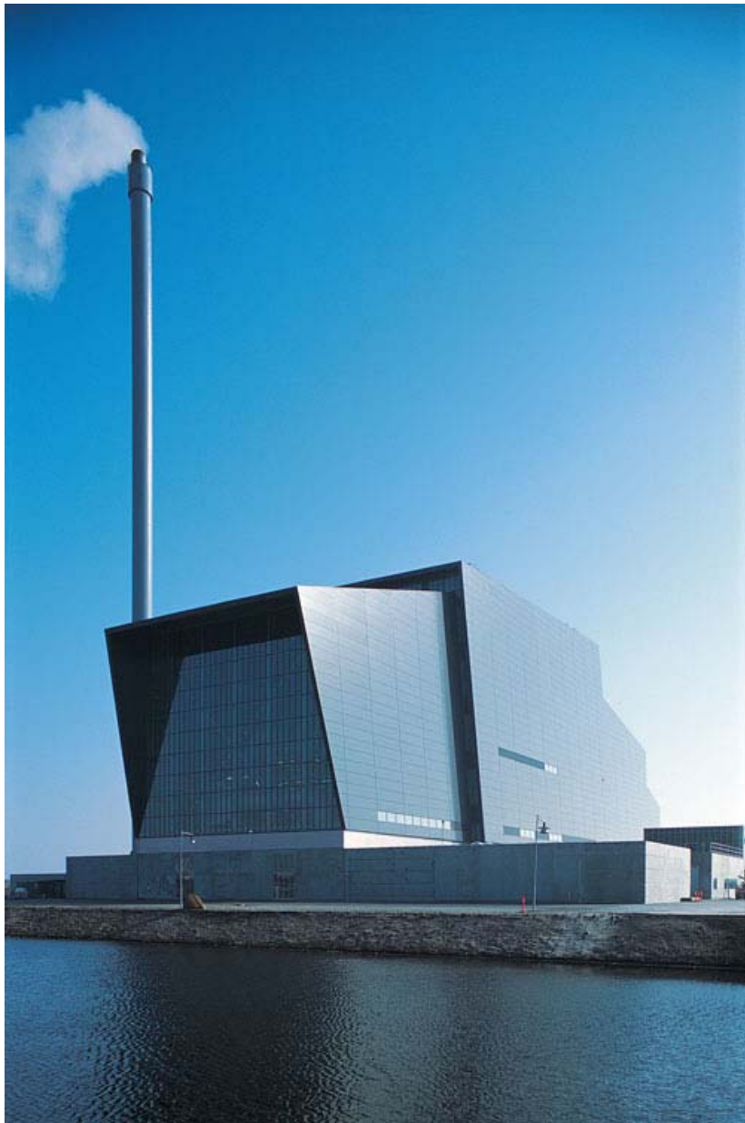
Hình 4.10. NMXLCTR tại Esbjerg, Đan Mạch - Kết cấu bao che bằng tấm alumi
