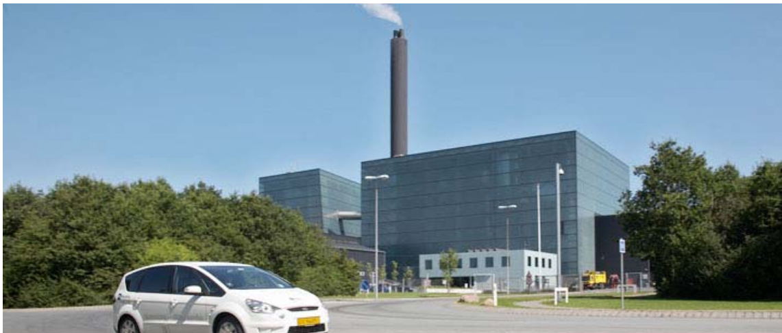
Hình 4.11. NMXLCTR tại Aarhus Nord, Đan Mạch - Kết cấu bao che bằng kính
