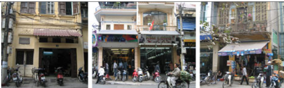
Hình 13. Không gian của đường phố lấn sâu vào trong nhà.
