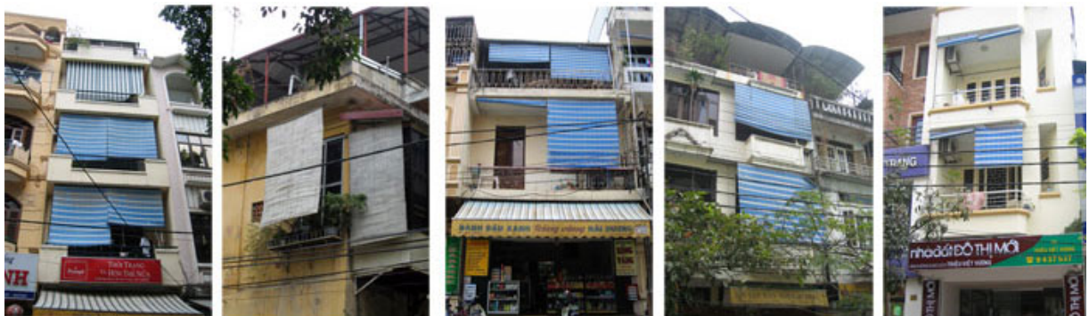
Hình 6. Màn rèm che nắng trên mặt đứng nhà ở.
