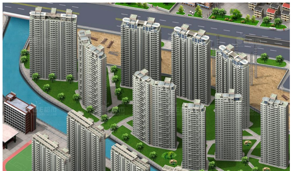
Hình 1. Một khu nhà ở cao tầng tại khu Phố Đông, Thượng Hải hiện nay
