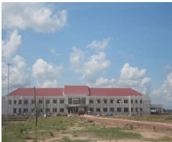
Bệnh viện huyện Bến Cầu (đang xây)
