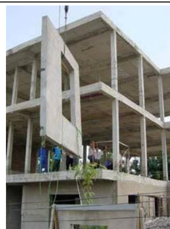
Công nghệ XD sử dụng bê tông nhẹ (nguồn: internet)
