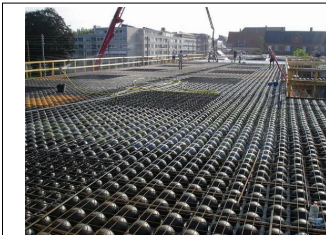
Công nghệ sàn bóng - Bubble Deck (nguồn: http://vitec.net.vn )
