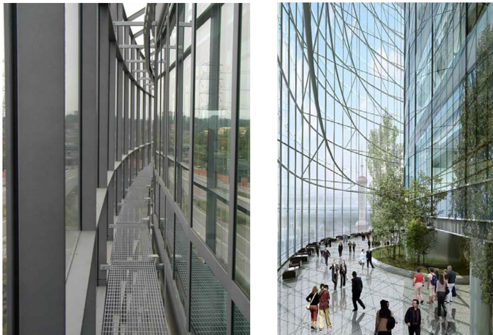
Hình 3.37 - Một số hình ảnh minh họa hệ chắn nắng 2 lớp trong các công trình công cộng trên thế giới
