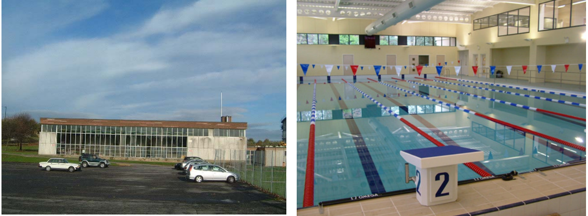
Hình 1.21 - Bể bơi có mái che-trường THPT Usworth School , Mỹ (Nguồn: Internet)
