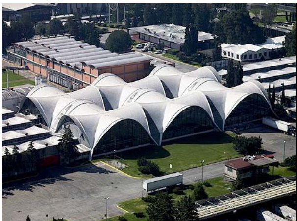
Kết cấu mái vòm cấu trúc hyperbol parabol được sử dụng trong xây dựng nhà máy rượu Rum Bacardi, (Bacardi Bottling Plant), tại Carretera, Mexico, do KTS người Tây Ban Nha Félix Candela thiết kế; Mái vòm có kích thước 30m x 30m cao 12m; Công trình hoàn thành năm 1959.
