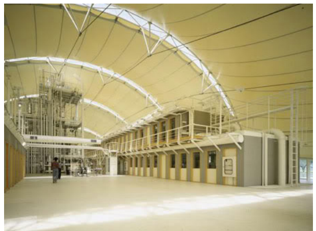
Trung tâm nghiên cứu và sản xuất của hãng hóa chất Ricerche, Venafrò, Ý (M&G Research Laboratory, Venafrò), hoàn thành 1992; có mặt bằng hình ô val 85m x 32m, bên trong không có cột; mái nhẹ bằng vải nhân tạo, được treo vào hệ khung thép ống dạng vòm có hình giọt nước. Các tấm mái nhẹ có cấu tạo để ánh nắng trực tiếp của mặt trời không xuyên qua nhưng lại tạo cho bề mặt mái phía trong có độ sáng như bầu trời tự nhiên..
