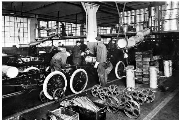
Năm 1910, xuất hiện dây chuyền lắp ráp liên tục di chuyển, trơn ven, là công nghệ quan trọng của sản xuất hàng loạt tại Nhà máy lắp ráp ô tô Ford, Highland Park, Michigan, Mỹ (Highland Park Ford Plant). Tỷ lệ lao động làm việc theo nhóm sản phẩm tăng dần.
