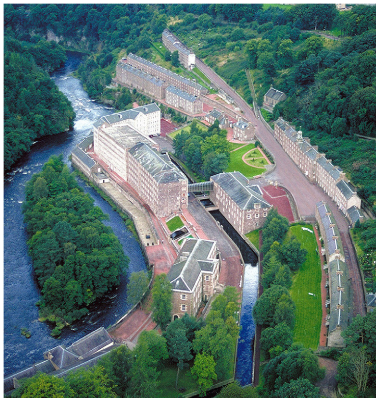
Nhà máy đặt cạnh suối, nguồn động lực cho sản xuất, kề liền là nhà ở cho công nhân
