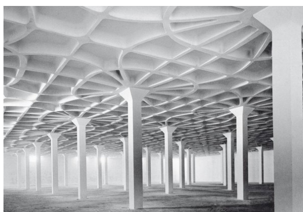
Nhà máy sản xuất len Gatti, Rome, Ý (Gatti Wool Factory) do Pier Luigi Nervi thiết kế vào năm 1953 với hệ thống kết cấu cột bê tông cốt thép, mái bằng xi măng lưới thép; là sự kết hợp hình học đơn giản và sản xuất lắp ghép hàng loạt.
