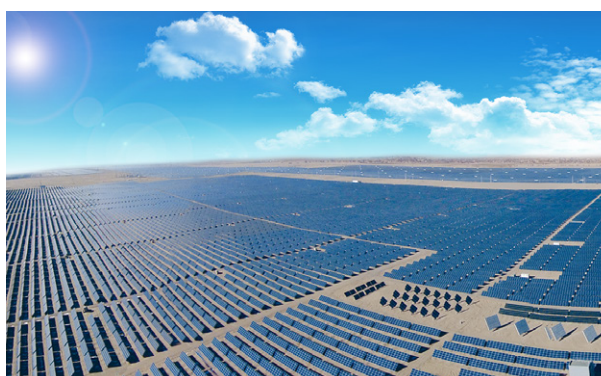
Nhà máy điện mặt trời Golmud, Thanh Hải, Trung Quốc, hoàn thành 2011.
