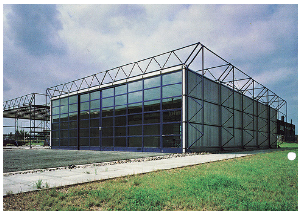
Công trình xây dựng theo cấu trúc xây dựng mô đun - Patera System do Michael Hopkins (KTS người Anh, 7/5/1935) đề xuất năm 1980. Sau khi hoàn thành móng, chỉ cần 2 công nhân với một cần cẩu nhỏ có thể dễ dàng lắp dựng xong công trình trong vòng 10 ngày.
