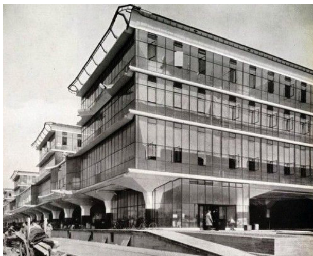
Nhà máy dược Boots Packed Wet, Nottingham, Anh (Boots Packed Wet Goods Factory). Công trình cao 4 tầng, khung BTCT, sàn nổi; hình thành 1930 - 1932
