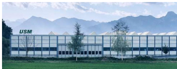
Mặt đứng nhà máy sản xuất đồ nội thất văn phòng USM Munsingen, Thụy Sĩ, hoàn thành 1979; được tổ hợp theo nguyên tắc mô đun tương tự như sản phẩm của hãng
