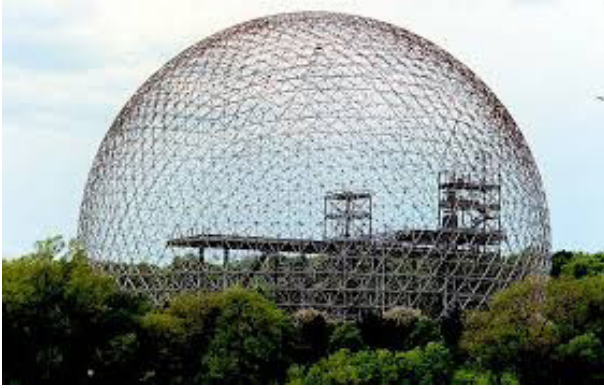
Mái vòm hình cầu (Geodesic Dome) do Buckminster Fuller (KTS, nhà phát minh người Mỹ 12/7/1895 - 1/7/1983) đề xuất vào năm 1947. Mái là một cấu trúc lưới dạng tam giác tạo thành một vỏ hình cầu hoặc bán cầu. Sử dụng hạn chế trong xây dựng công nghiệp so với dân dụng.
