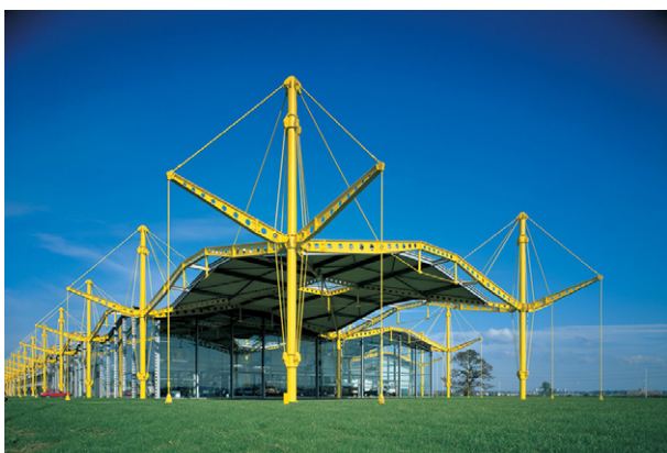
Trung tâm sản xuất, phân phối ô tô Renault, Swindon, Anh (Renault Distribution Centre) do KTS Norman Forster thiết kế, hoàn thành năm 1982; là một ví dụ tiêu biểu về phong cách Kiến trúc High-tech với những giá trị thẩm mỹ mới gắn với yếu tố công nghệ. Khối kiến trúc của công trình dường như chỉ gắn vào mặt đất qua các cột thép rất thanh mảnh, tạo cảm giác công trình như được đặt nhẹ lên thảm cỏ, xóa đi ấn tượng “chiếm chỗ” thường thấy ở các công trình công nghiệp.
