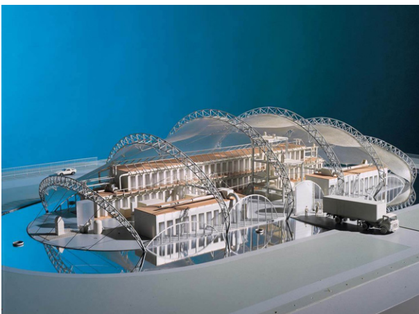
Trung tâm nghiên cứu và sản xuất của hãng hóa chất Ricerche, Venafrò, Ý (M&G Research Laboratory, Venafrò), hoàn thành 1992; có mặt bằng hình ô val 85m x 32m, bên trong không có cột; mái nhẹ bằng vải nhân tạo, được treo vào hệ khung thép ống dạng vòm có hình giọt nước. Các tấm mái nhẹ có cấu tạo để ánh nắng trực tiếp của mặt trời không xuyên qua nhưng lại tạo cho bề mặt mái phía trong có độ sáng như bầu trời tự nhiên..
