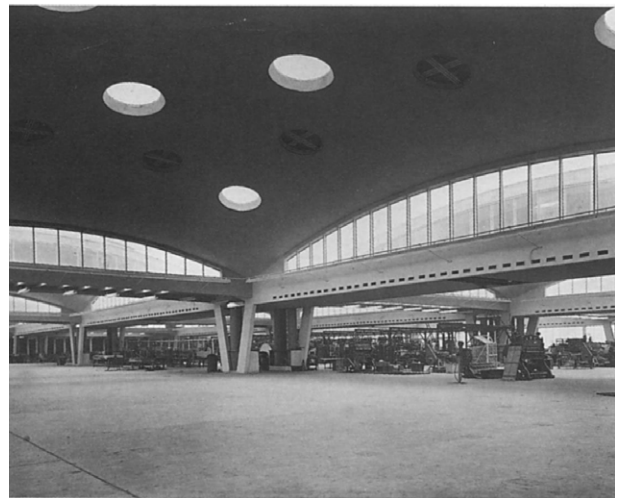
Kết cấu mái vòm BTCT tại Nhà máy cao su Brynmawr, Wales (Brynmawr Rubber Factory), năm 1951
