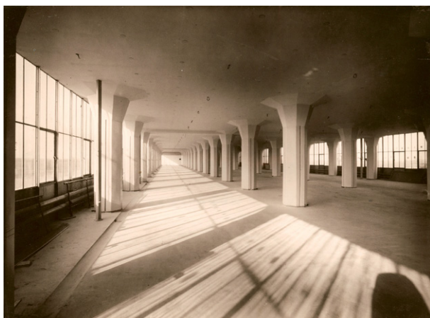
Nhà máy sản xuất cà phê, trà, thuốc lá Van Nelle, Rotterdam, Hà Lan (Van Nelle Fabriek) . Công trình cao 3 - 8 tầng, kết cấu khung BTCT toàn khối, dạng sàn nổi; hình thành 1925 - 1931
