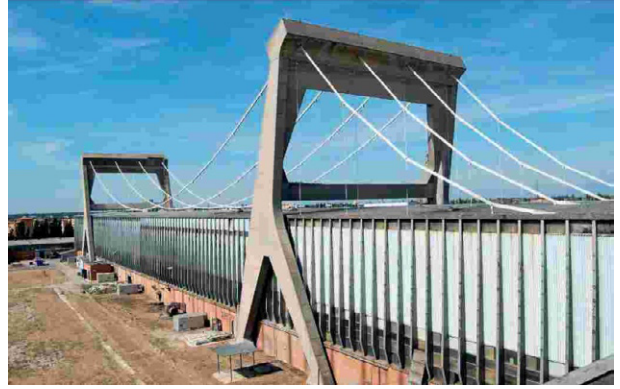
Nhà máy giấy Cartiera Burgo, Mantua, Ý (Cartiere Burgo a Mantova) do kỹ sư người Ý Pier Luigi Nervi thiết kế vào năm 1960 - 1964. Toàn bộ công trình dài 250m, rộng 160m. Mái nhà được treo vào hai khung trụ bằng BTCT cao 50m, đặt nghiêng, có chân đỡ tạo thành hình chữ Y.
