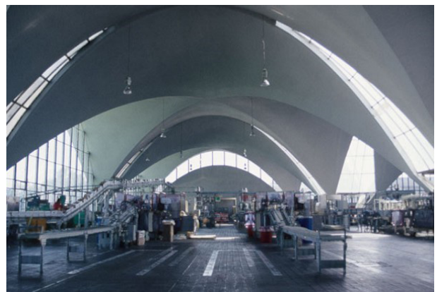
Kết cấu mái vòm cấu trúc hyperbol parabol được sử dụng trong xây dựng nhà máy rượu Rum Bacardi, (Bacardi Bottling Plant), tại Carretera, Mexico, do KTS người Tây Ban Nha Félix Candela thiết kế; Mái vòm có kích thước 30m x 30m cao 12m; Công trình hoàn thành năm 1959.
