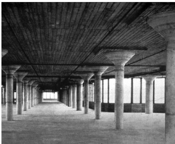
Công trình nhà kho Starrett-Lehigh, New York, Mỹ (Starrett-Lehigh Building New York) cao 15 - 19 tầng, khung BTCT, sàn nổi, hình thành 1931
