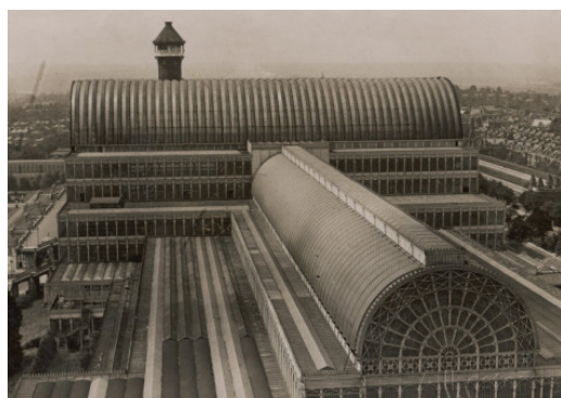
Cung thủy tinh - công trình Triển lãm Thế giới ở Luân Đôn, do Joseph Paxton xây dựng bằng phương pháp lắp ghép vào năm 1850 - 1851, là công trình mở đầu cho Kiến trúc Hiện đại (Modern Architecture)
