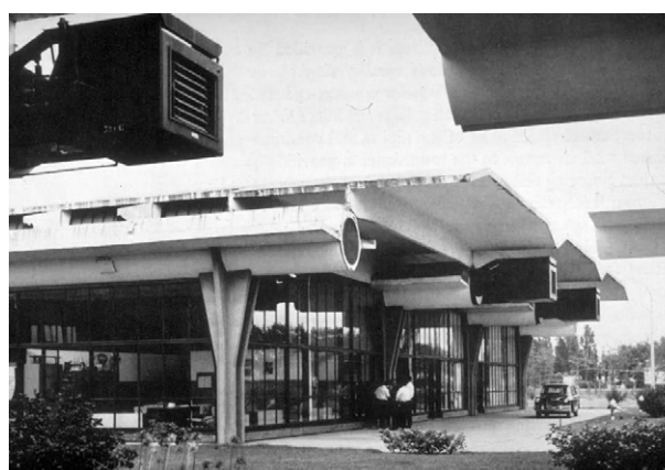
Nhà máy sản xuất máy đánh chữ Olivetti, Buenos Aires, Argentina (Olivetti Factories, Buenos Aires), hoàn thành 1955-1957 do KTS người Ý Marco Zanuso thiết kế; sử dụng dầm BTCT dự ứng lực, dầm dầm rỗng, bên trong là không gian bố trí hệ thống kỹ thuật.
