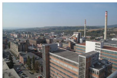
Nhà máy sản xuất giày
