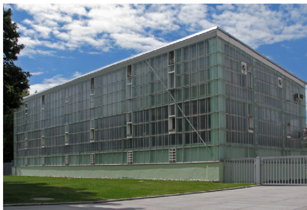
Công trình kiến trúc công nghiệp với tường “rèm kính” lấy ánh sáng đầu tiên - Nhà máy sản xuất đồ chơi Steiff-Spielzeugfabrik, Giengen, Đức; hình thành vào năm 1903.
