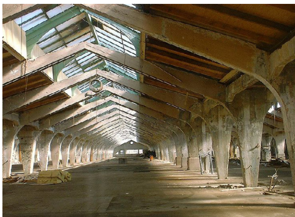
Nhà máy sản xuất mũ Luckenwalde, Đức (Hutfabrik in Luckenwalde); Khung chịu lực bằng BTCT; Cửa lấy ánh sáng trên mái; hình thành 1920
