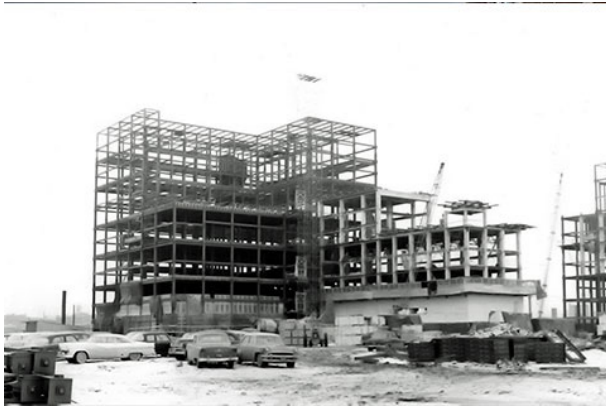
Nhà máy sản xuất đường Redpath, Toronto, Canada (Redpath Sugar Factory, Toronto); hoàn thành 1958; là một tổ hợp công nghiệp thực phẩm lớn hàng đầu tại Canada thời bấy giờ với cấu trúc xây dựng nhiều tầng rất điển hình bằng khung thép và BTCT.
